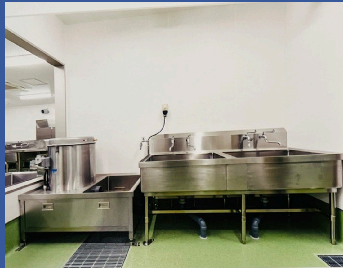
根莖類前處理室
