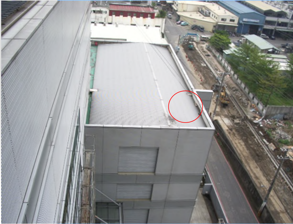
清洗作業區，輸配電線路與屋頂間距約4.7公尺
